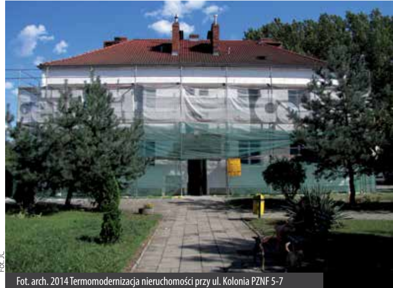
Fot. arch. 2014 Termomodernizacja nieruchomości przy ul. Kolonia PZNF 5-7
