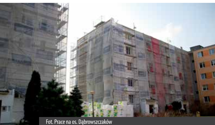
Fot. Prace na os. Dąbrowszczaków
