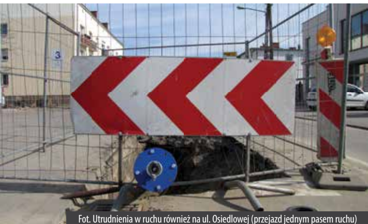
Fot. Utrudnienia w ruchu również na ul. Osiedlowej (przejazd jednym pasem ruchu)
