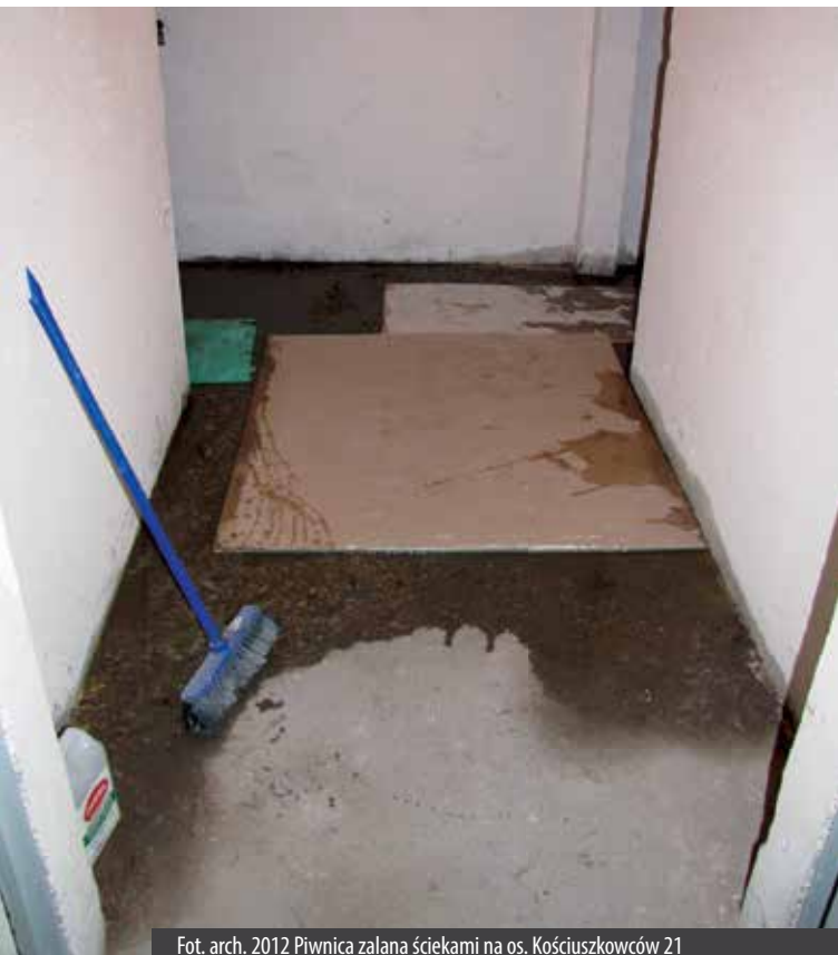
Fot. arch. 2012 Piwnica zalana ściekami na os. Kościuszkowców 21
