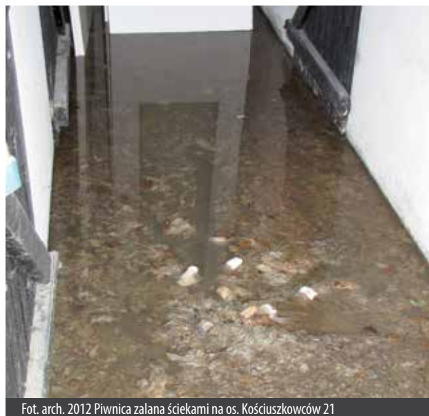
Fot. arch. 2012 Piwnica zalana ściekami na os. Kościuszkowców 21
