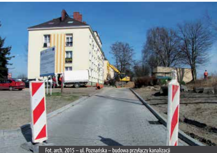
Fot. arch. 2015 – ul. Poznańska – budowa przyłączy kanalizacji
