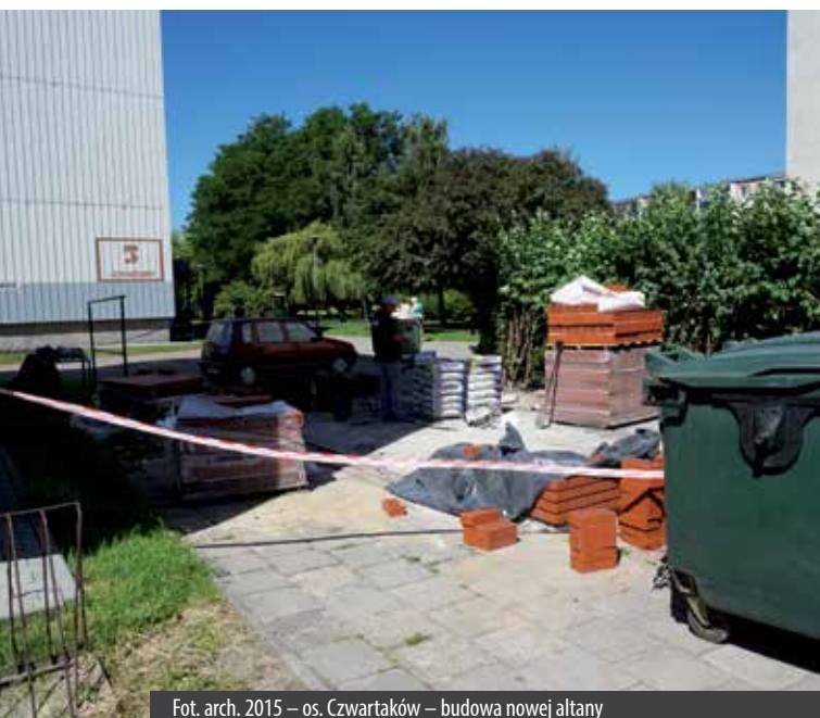
Fot. arch. 2015 – os. Czwartaków – budowa nowej altany
