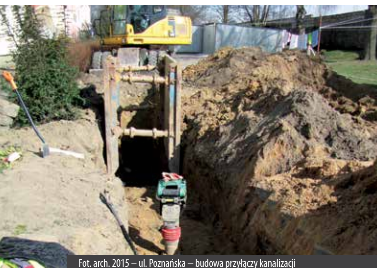
Fot. arch. 2015 – ul. Poznańska – budowa przyłączy kanalizacji
