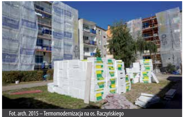
Fot. arch. 2015 – Termomodernizacja na os. Raczyńskiego
