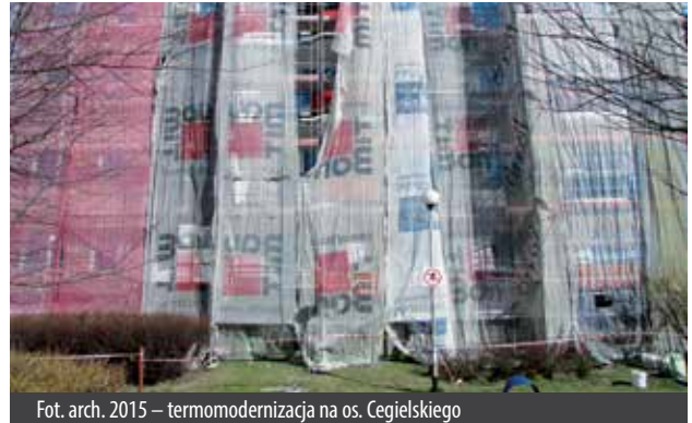
Fot. arch. 2015 – termomodernizacja na os. Cegielskiego
