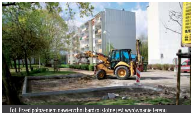
Fot. Przed położeniem nawierzchni bardzo istotne jest wyrównanie terenu
