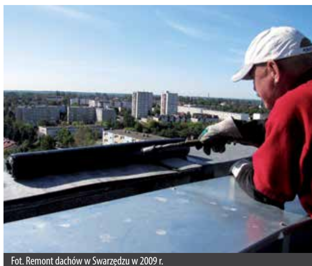
Fot. Remont dachów w Swarzędzu w 2009 r.
