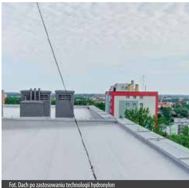
Fot. Dach po zastosowaniu technologii hydronylon
