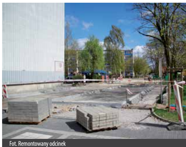
Fot. Remontowany odcinek
