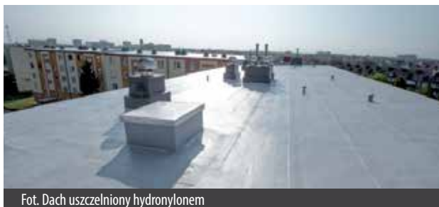
Fot. Dach uszczelniony hydronylonem
