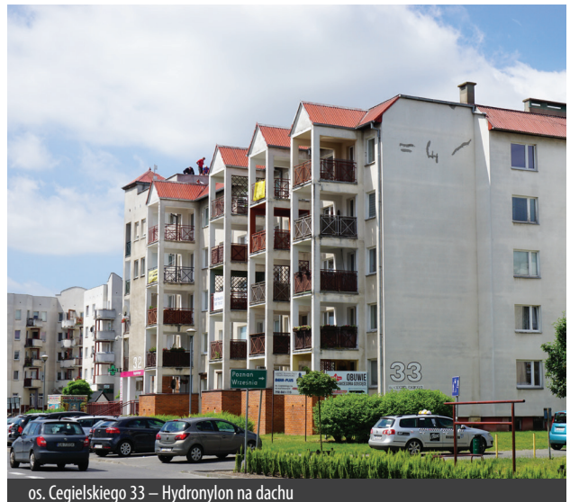
os. Cegielskiego 33 – Hydronylon na dachu
