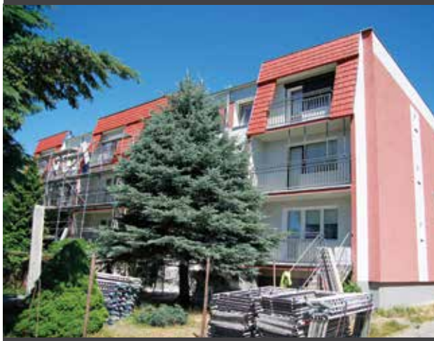
ul. Gryniów 3. Prace na zachodniej stronie budynku
