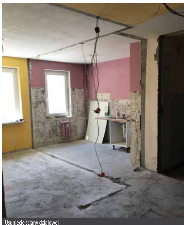
Usunięcie ściany działowej
