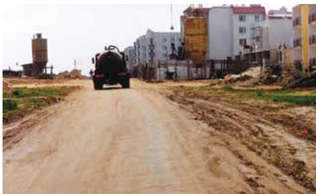
Budowa dzielnicy Swarzędz-Południe
