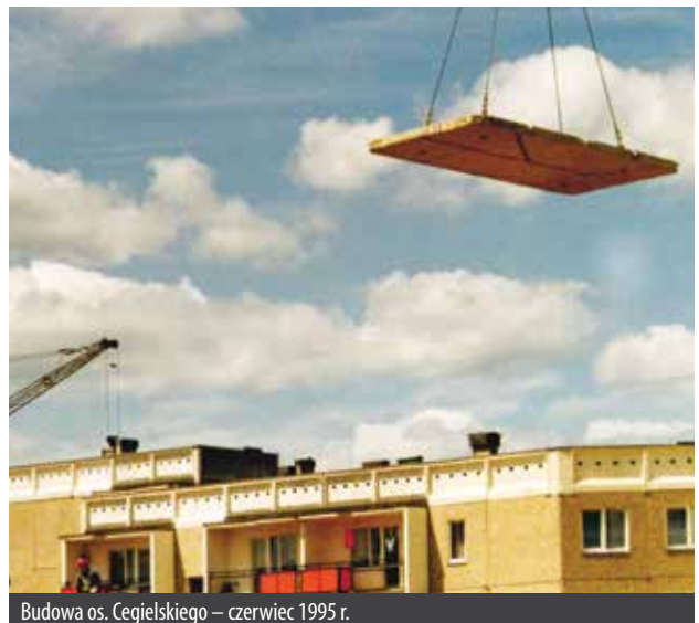
Budowa os. Cegielskiego – czerwiec 1995 r.
