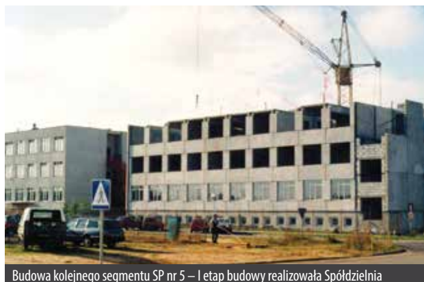
Budowa kolejnego segmentu SP nr 5 – I etap budowy realizowała Spółdzielnia
