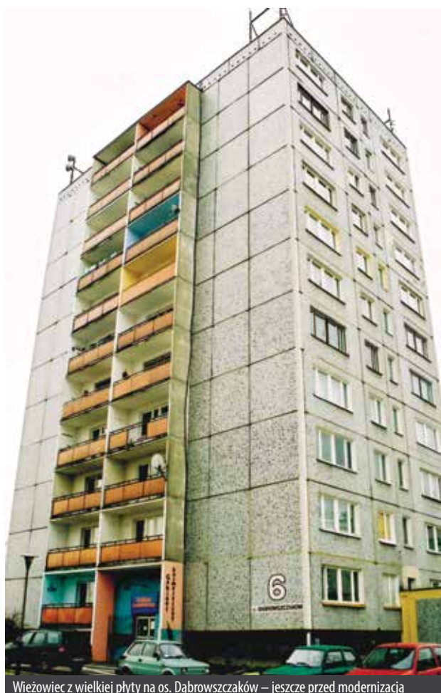
Wieżowiec z wielkiej płyty na os. Dąbrowszczaków – jeszcze przed modernizacją
