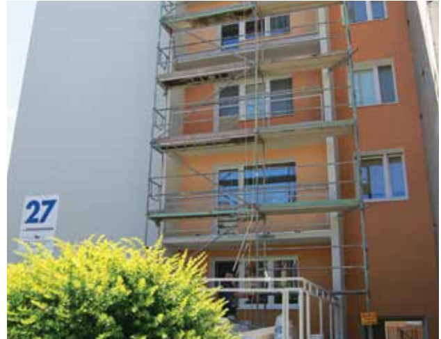
os. Kościuszkowców 27. Remonty na bocznej stronie bloku
