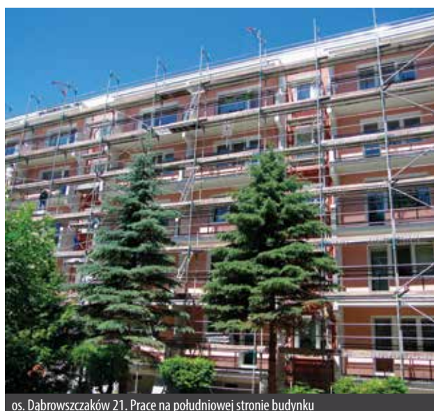
os. Dąbrowszczaków 21. Prace na południowej stronie budynku
