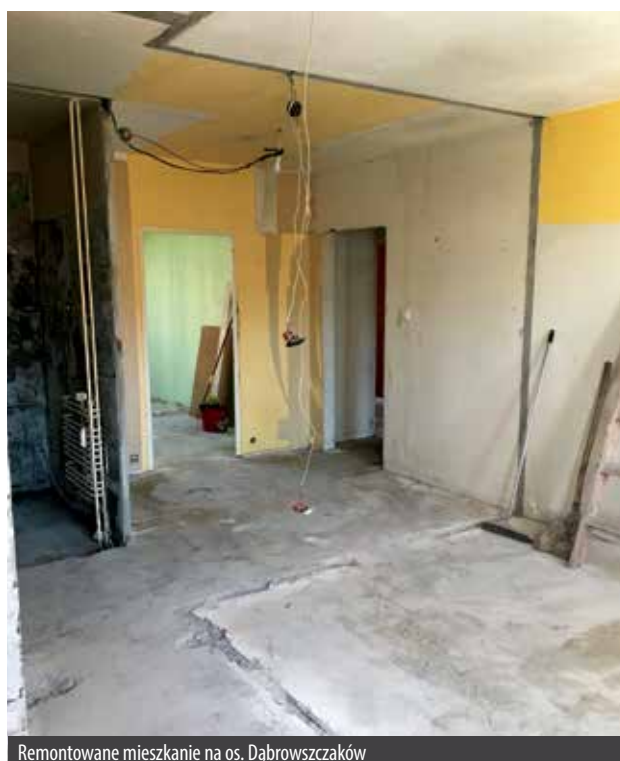
Remontowane mieszkanie na os. Dąbrowszczaków
