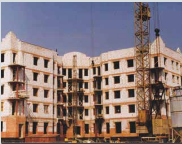
Budowa bloków nr 19 i 20 na os. Raczyńskiego
