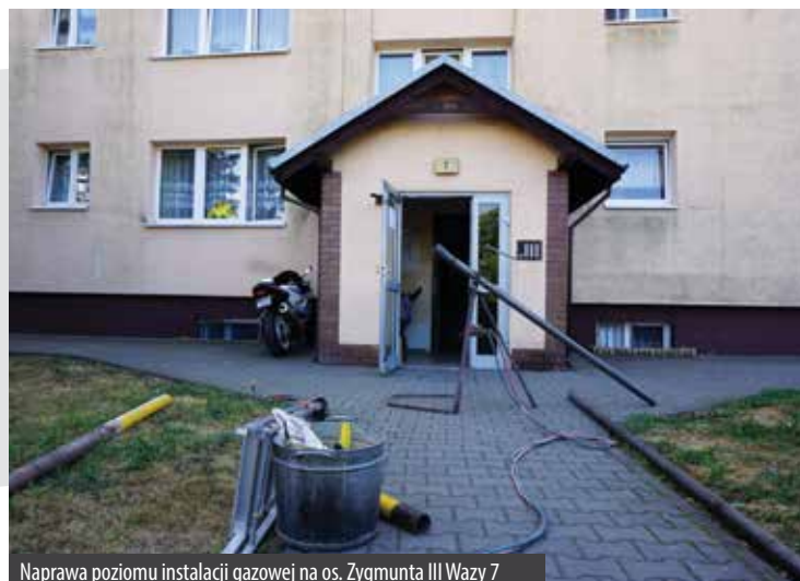
Naprawa poziomu instalacji gazowej na os. Zygmunta III Wazy 7
