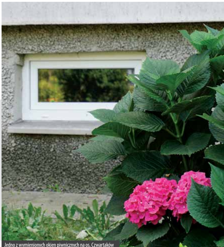
Jedno z wymienionych okien piwnicznych na os. Czwartaków
