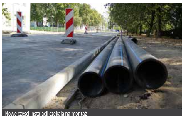
Nowe części instalacji czekają na montaż
