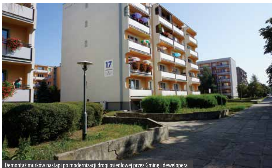
Demontaż murków nastąpi po modernizacji drogi osiedlowej przez Gminę i developera
