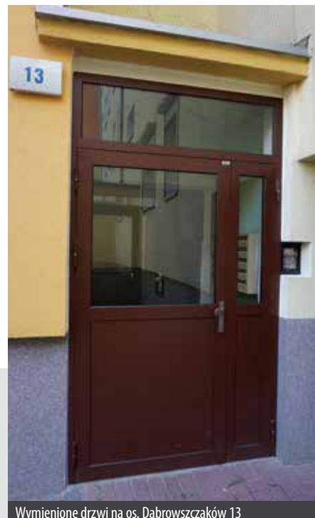
Wymienione drzwi na os. Dąbrowszczaków 13
