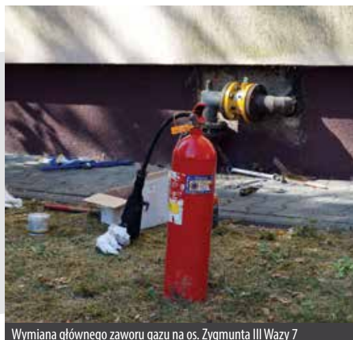
Wymiana głównego zaworu gazu na os. Zygmunta III Wazy 7
