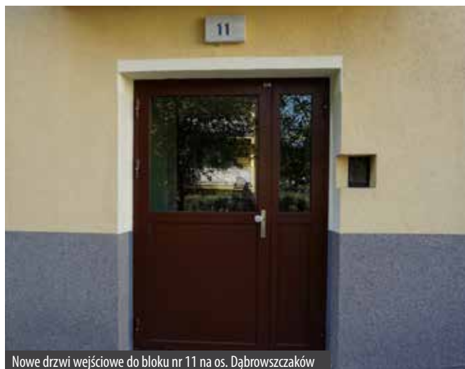
Nowe drzwi wejściowe do bloku nr 11 na os. Dąbrowszczaków
