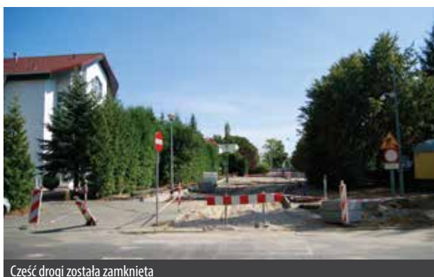
Część drogi została zamknięta
