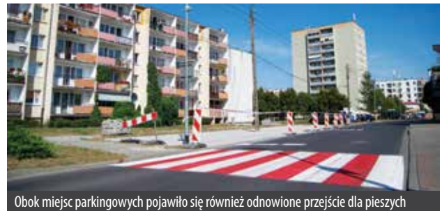
Obok miejsc parkingowych pojawiło się również odnowione przejście dla pieszych
