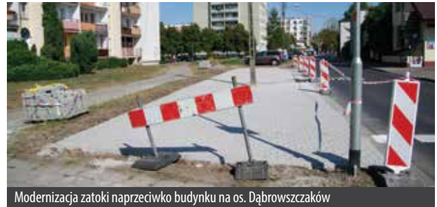
Modernizacja zatoki naprzeciwko budynku na os. Dąbrowszczaków
