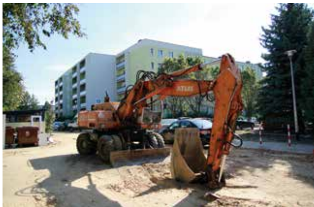
Koparki gotowe do pracy
