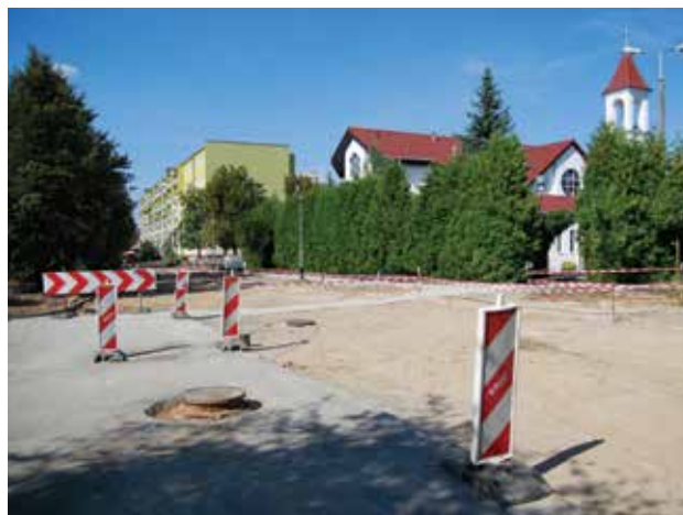
Pomiędzy SP nr 4 a kościołem zostały wyznaczone przejścia
