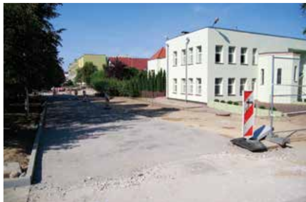
Przy SP nr 4 została częściowo położona nowa nawierzchnia
