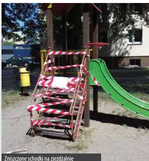
Zniszczone schodki na zjeżdżalnię
