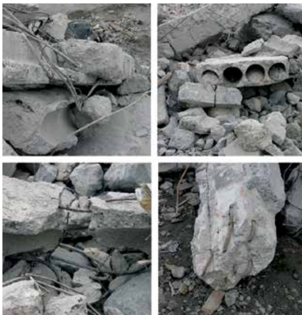
Widok elementów prefabrykowanych i ich zbrojenia podczas rozbioru budynku wielkopłytowego /źródło: J. Szulc/
