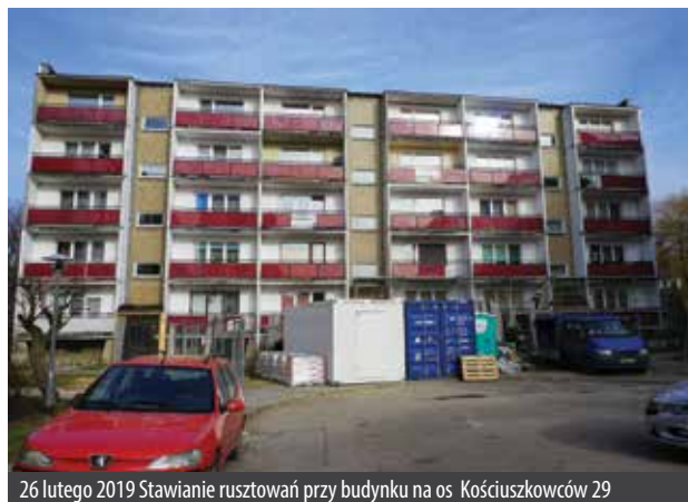
26 lutego 2019 Stawianie rusztowań przy budynku na os. Kościuszkowców 29
