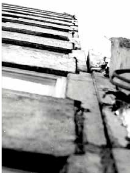
Katastrofa budowlana wznoszonego segmentu budynku w Polkowicach w 1979 r. wynikająca z błędów projektowych systemu, niskiej jakości produkcji prefabrykatów i ich montażu /źródło: ITB/
