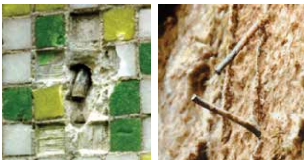
Przykłady pęknięcia wieszaków stalowych warstwy fakturowej ścian zewnętrznych /źródło: M. Wójtowicz
