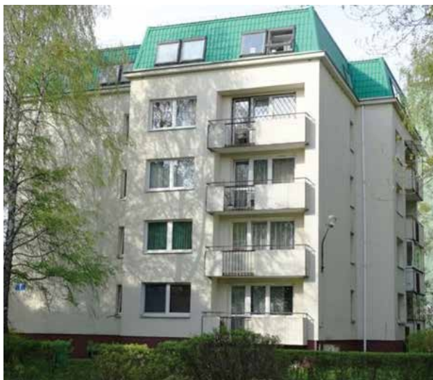
Przykłady nadbudowy budynków wielkopłytowych i dobudowy zewnętrznych klatek schodowych (z szybami windowymi) /źródło: J. Szulc/
