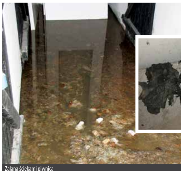
Zalana ściekami piwnica
