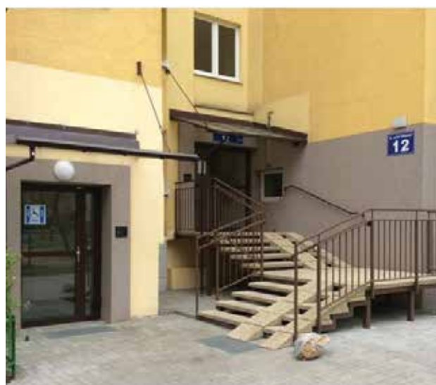
Przykład wykorzystania komory zsykowej do montażu dźwigu osobowego – umożliwienie swobodnej komunikacji dla osób niepełnosprawnych /źródło: J. Szulc/
