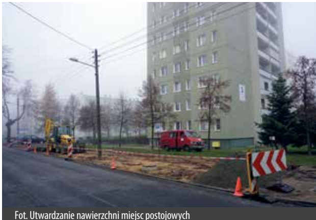
Fot. Utwardzanie nawierzchni miejsc postojowych
