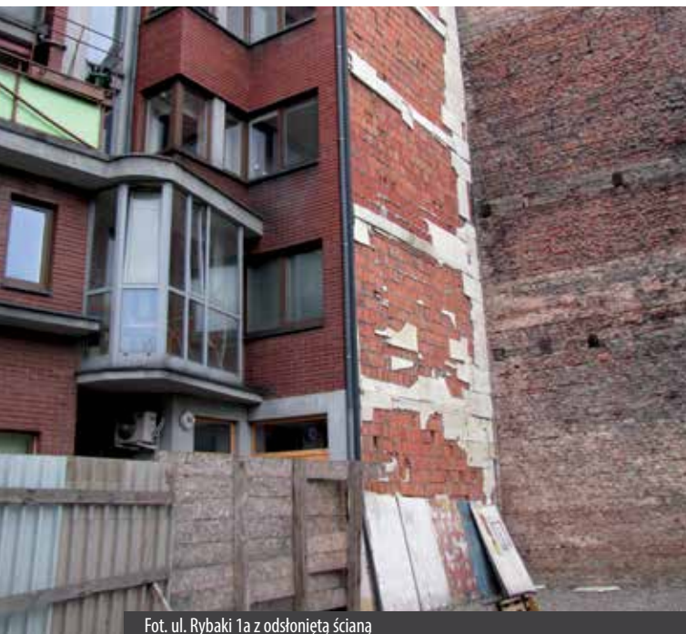
Fot. ul. Rybaki 1a z odsłoniętą ścianą
