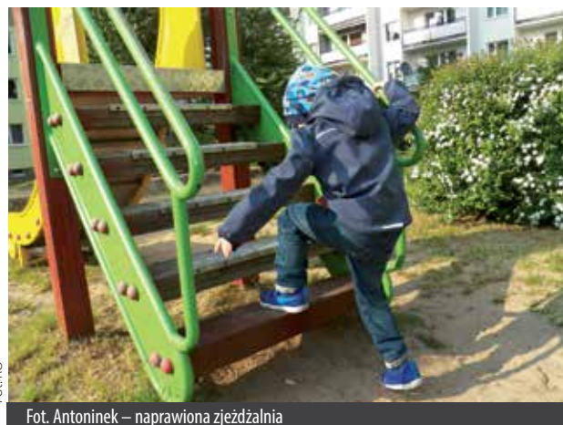
Fot. Antoninek – naprawiona zjeżdżalnia
