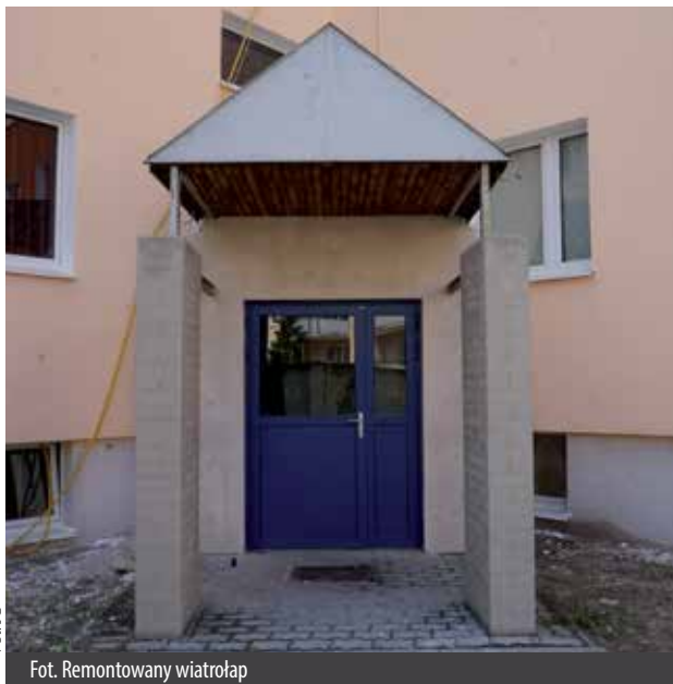
Fot. Remontowany wiatrolap
