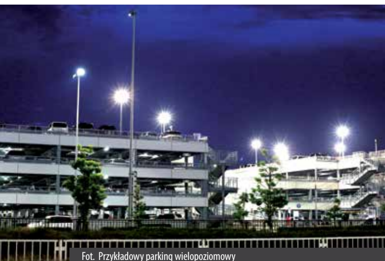
Fot. Przykładowy parking wielopoziomowy
