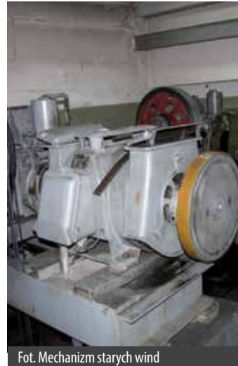
Fot. Mechanizm starych wind
