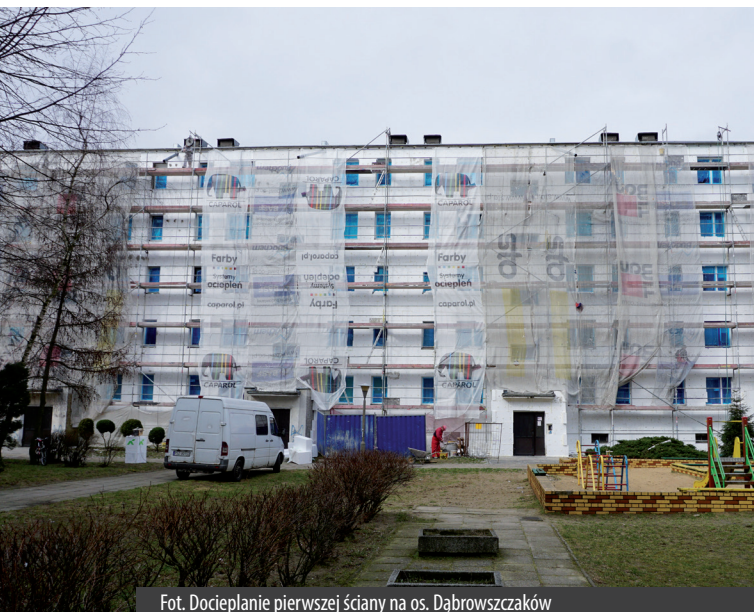
Fot. Docieplanie pierwszej ściany na os. Dąbrowszczaków
