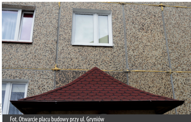
Fot. Pierwszy etap prac - uszczelnianie ubytków w elewacji
