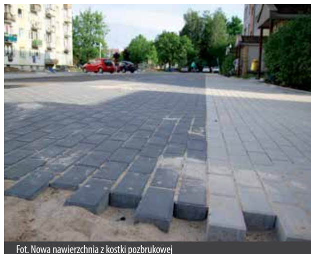
Fot. Nowa nawierzchnia z kostki pozbrukowej
