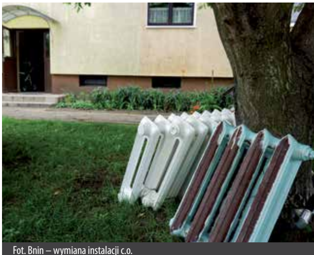
Fot. Bnin – wymiana instalacji c.o.
