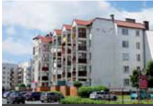
Fot. os. Cegielskiego 33 – remont dachu
