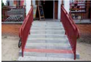
Fot. os. Cegielskiego 33 – remont schodów
