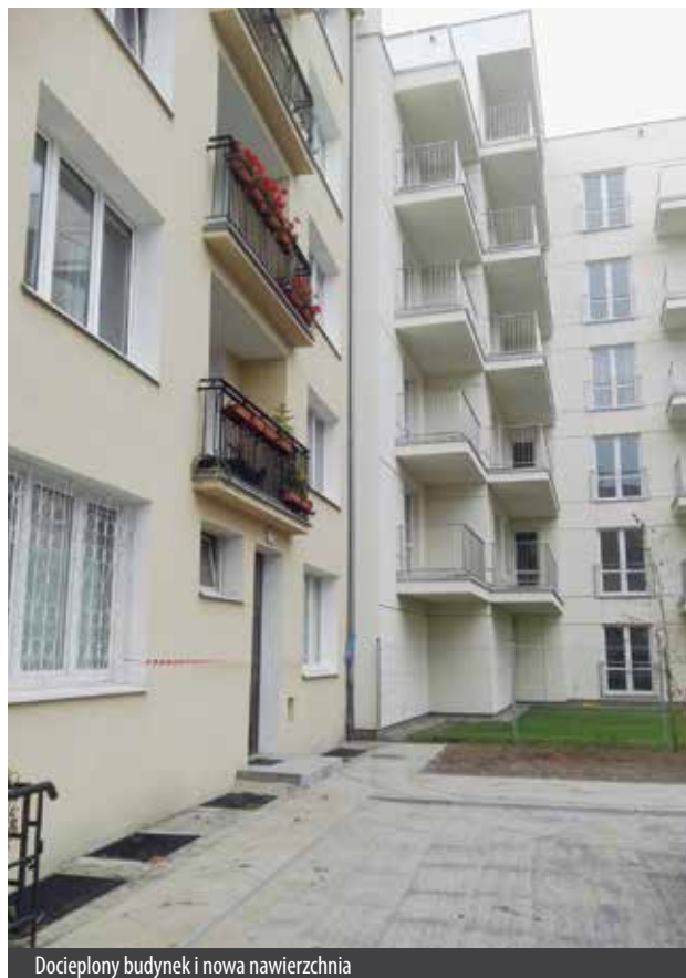
Docieplony budynek i nowa nawierzchnia
