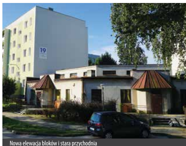
Nowa elewacja bloków i stara przychodnia
