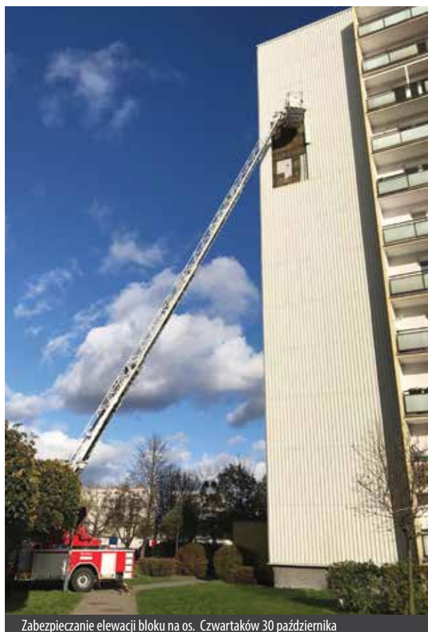
Zabezpieczanie elewacji bloku na os. Czwartaków 30 października
