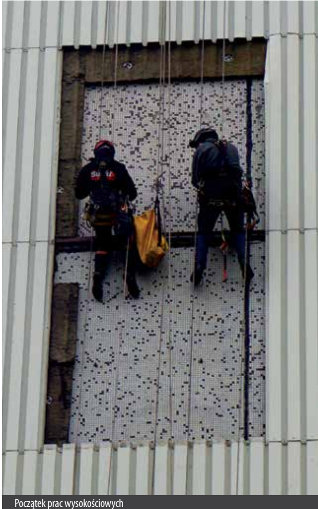
Początek prac wysokościowych
