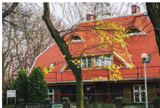
Zabytkowy dach z dekoracyjnymi „wolimi oczami”
