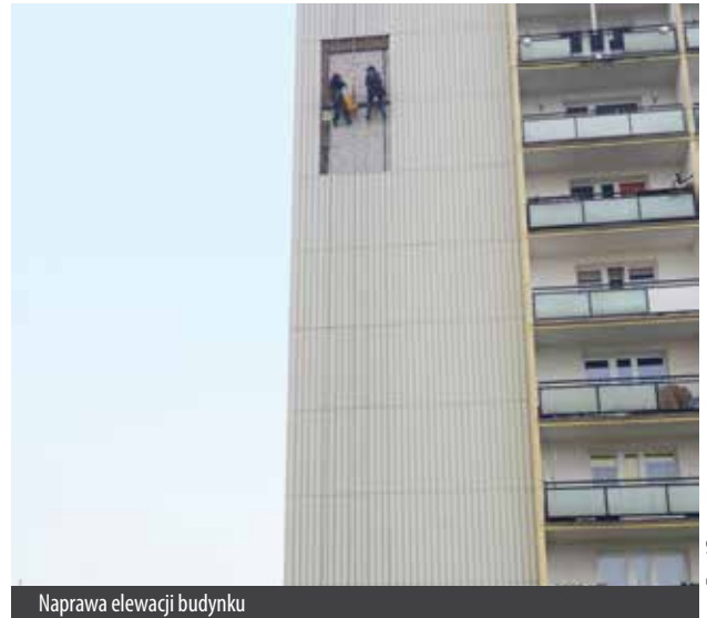
Naprawa elewacji budynku
