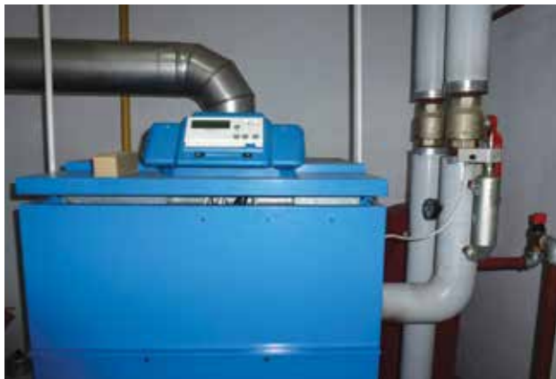
Kotłownia – Czerwonak, ul. Gdyńska 122
