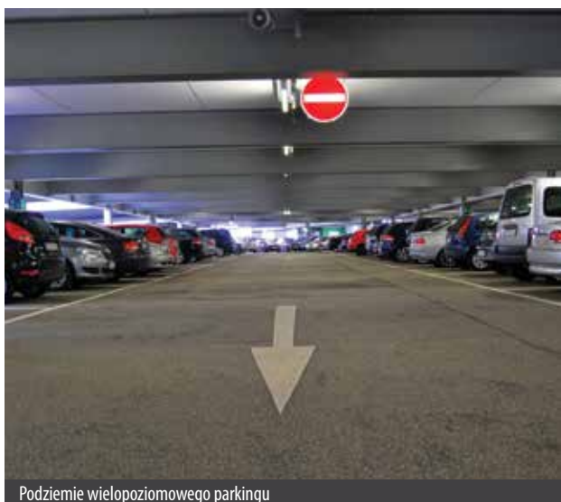
Podziemie wielopoziomowego parkingu
