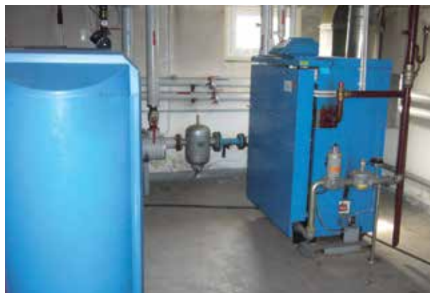
Kotłownia – Kostrzyn, ul. Piasta 3
