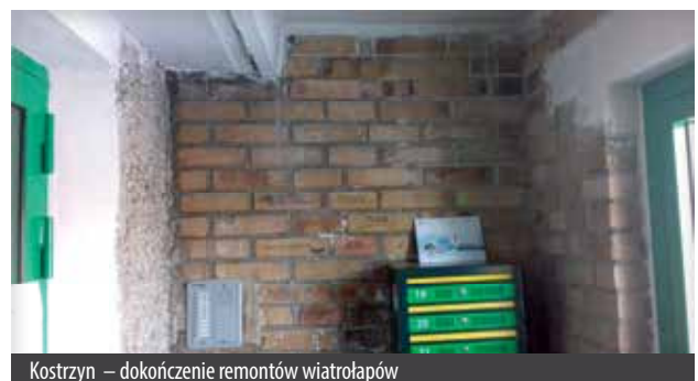
Kostrzyn – dokończenie remontów wiatrołapów
