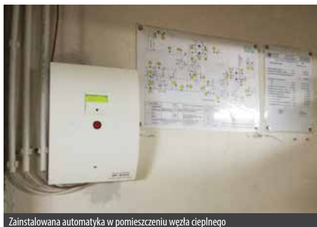
Zainstalowana automatyka w pomieszczeniu węzła cieplnego
