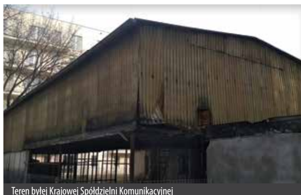
Teren byłej Krajowej Spółdzielni Komunikacyjnej
