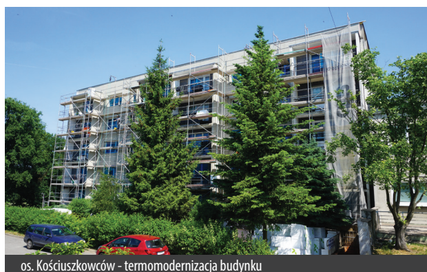
os. Kościuszkowców - termomodernizacja budynku
