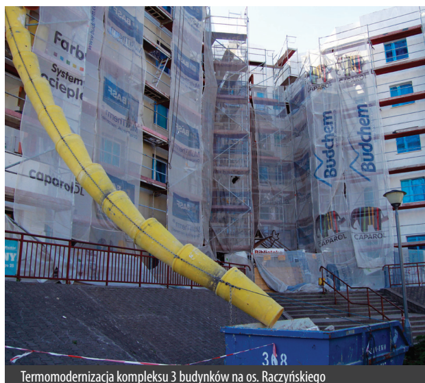
Termomodernizacja kompleksu 3 budynków na os. Raczyńskiego
