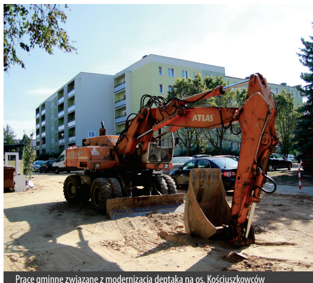
Prace gminne związane z modernizacją deptaka na os. Kościuszkowców
