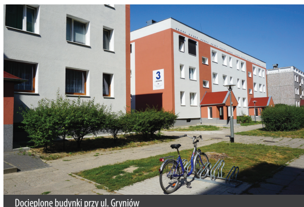
Dociepłone budynki przy ul. Gryniów
