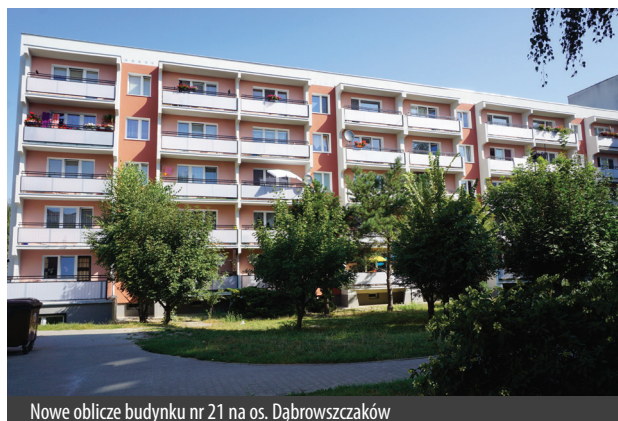
Nowe oblicze budynku nr 21 na os. Dąbrowszczaków
