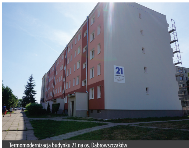
Termomodernizacja budynku 21 na os. Dąbrowszczaków
