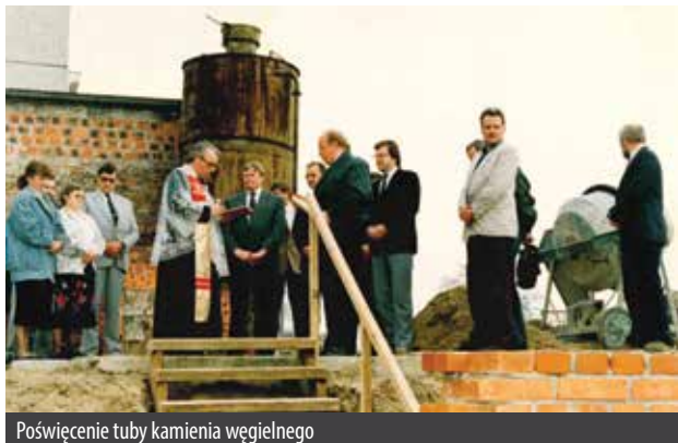
Poświęcenie tuby kamienia węgielnego
