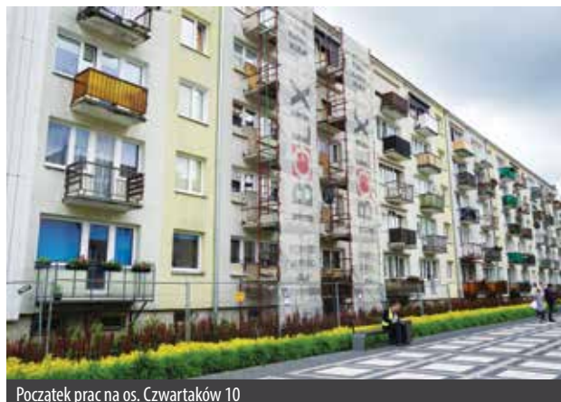
Początek prac na os. Czwartaków 10
