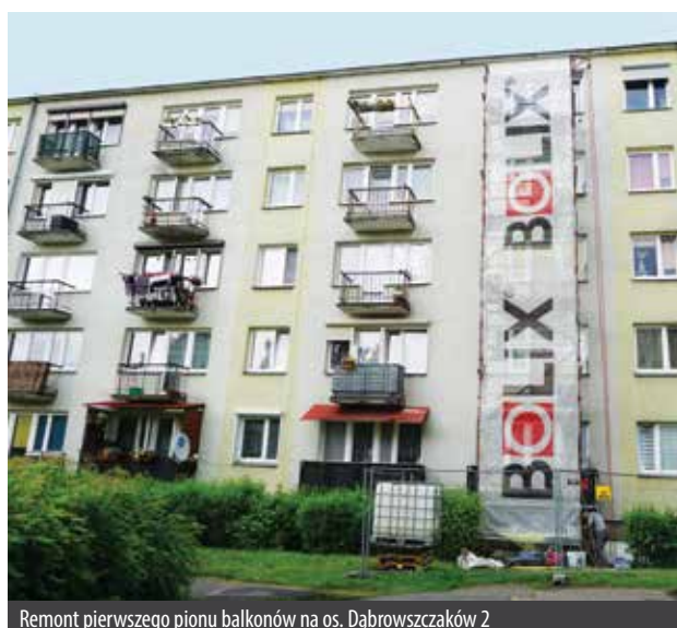
Remont pierwszego pionu balkonów na os. Dąbrowszczaków 2
