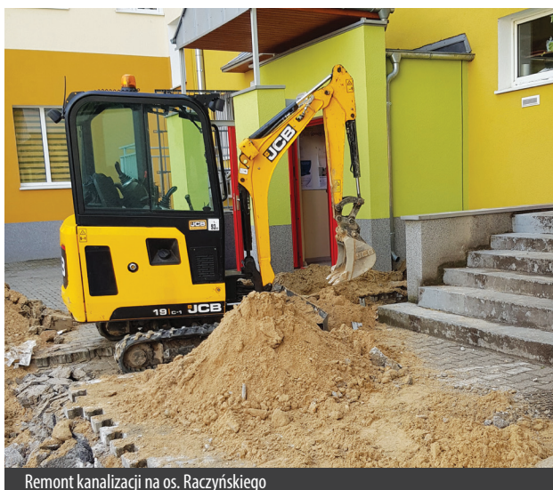
Remont kanalizacji na os. Raczyńskiego
