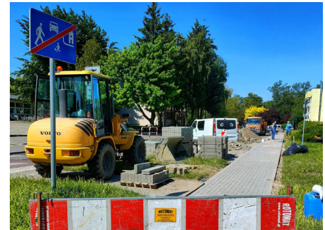
Remont chodnika w Kostrzynie. 2023 r.
