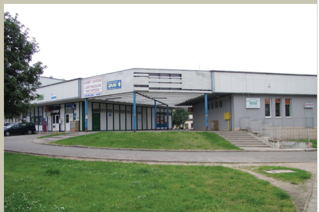
Szanse na tchnięcie życia w nieużytkowane powierzchnie obiektu na os. Kościuszkowców 13
