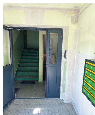
os. Czwartaków - w trakcie prac
