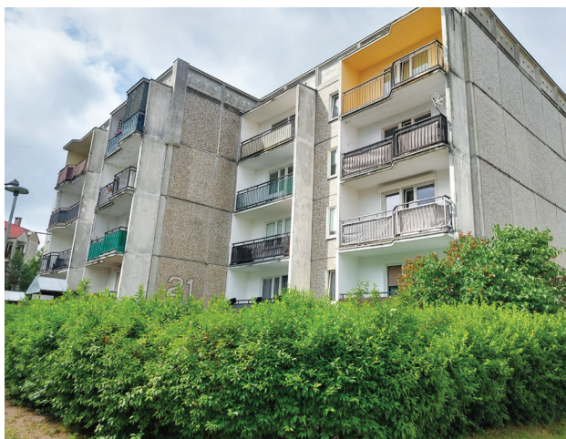
Budynki przed dociepleniem
