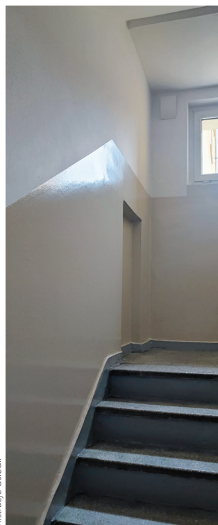
os. Dąbrowszczaków - klatka schodowa po malowaniu
