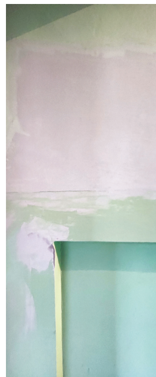
os. Dąbrowszczaków 11 - wyrównywanie ubytków
