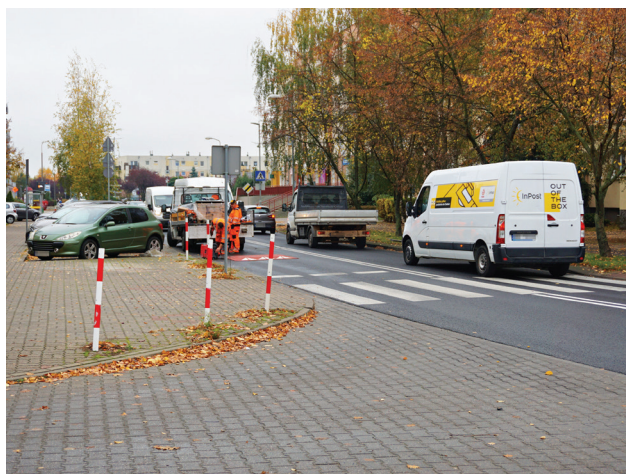
Montaż progów – 29 października 2024 r.
