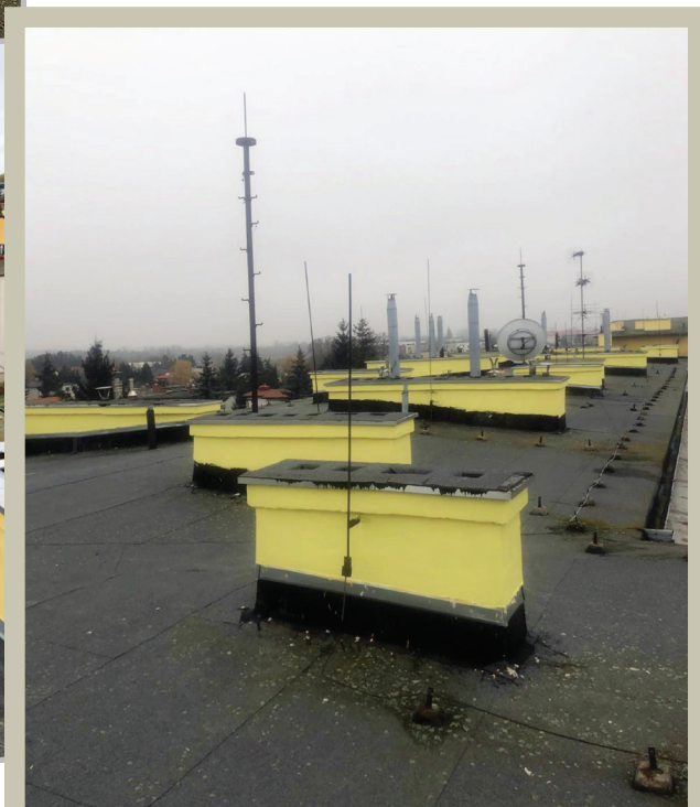
Lubon, ul. Asnyka 5, 6, 7 – prace zakończone
