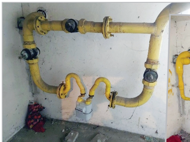
Kościuszkowców 22 – przed remontem
