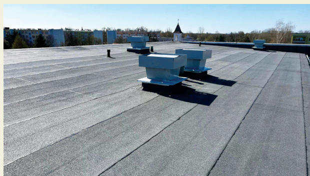
WYMIANA POKRYCIA DACHU – os. Kościuszkowców 5
