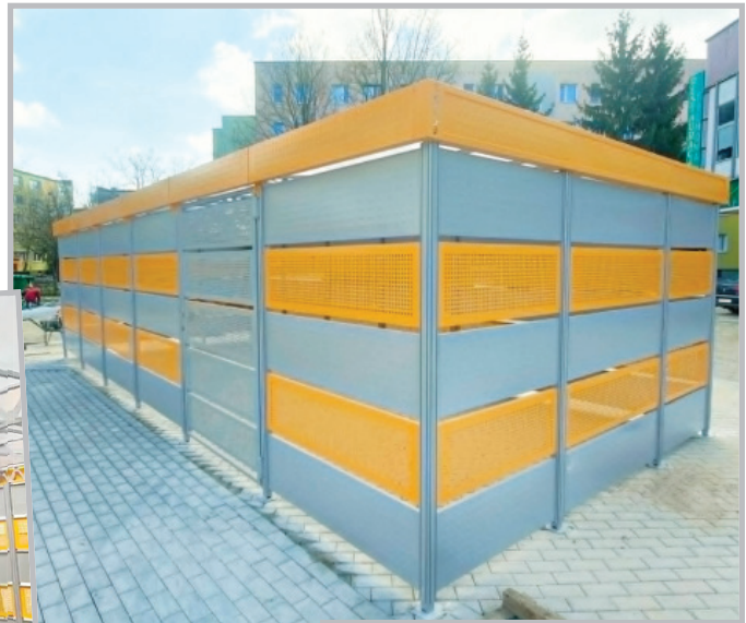
Altana śmietnikowa przy budynku nr 11
