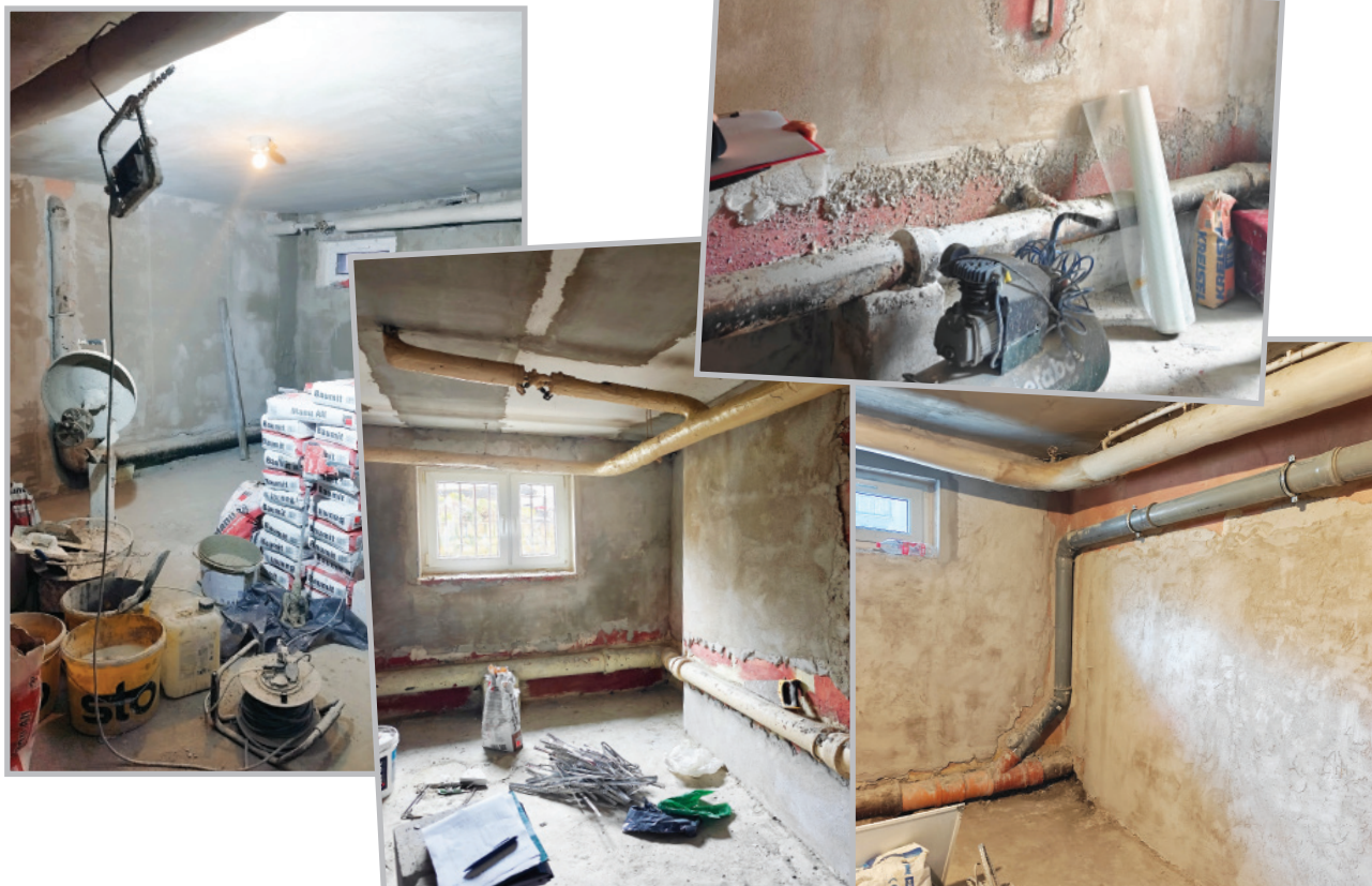
Wydzielenie i przygotowywanie przez Spółdzielnię pomieszczeń (pod nowe węzły) oraz instalacji
