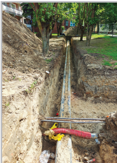
Budowa sieci wysokoparametrowych i przyłączy do budynków przez firmę VEOLIA
