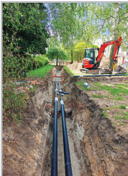
Budowa sieci wysokoparametrowych i przyłączy do budynków przez firmę VEOLIA
